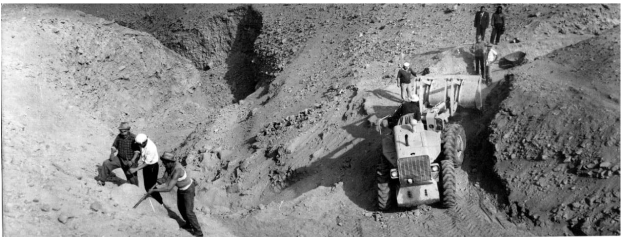
Figura 3: Voluntarios del comando en pleno trabajo. Podemos ver un cargador frontal abriendo la vía de penetración, 30 de mayo de 1971.
